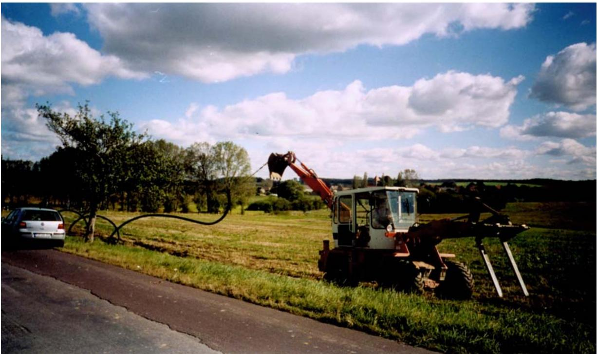
Und schon sind Knicke und potentielle Undichtigkeiten in den Rohren als sicher anzunehmen.
